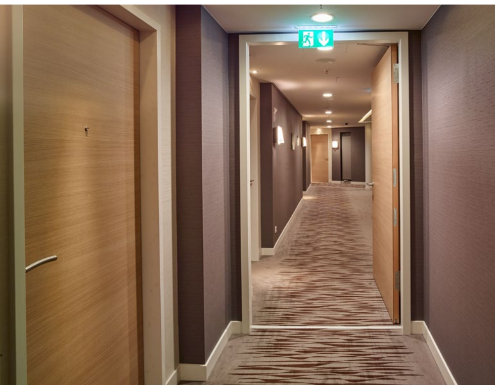
VLAVO. Oceľové zárubne s vysokokvalitnými drevenými protipožiarnymi dverami
