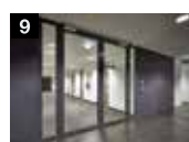
9 Plne presklené prvky rúrkového rámu
